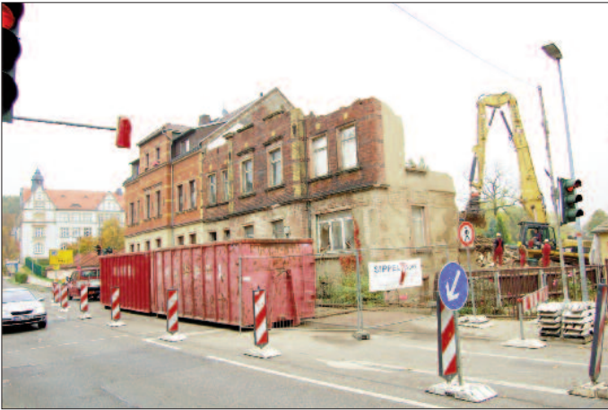
Abrissarbeiten an der Augustusburger Straße 6.
