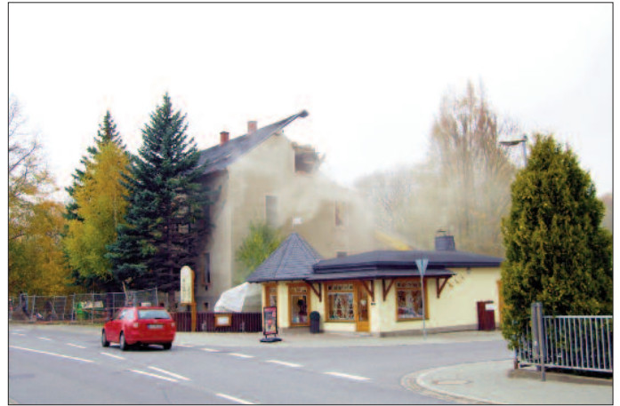
Mit dem Abriss der Augustusburger Straße 120 verschwindet ein weiterer Schandfleck in Flöha.
