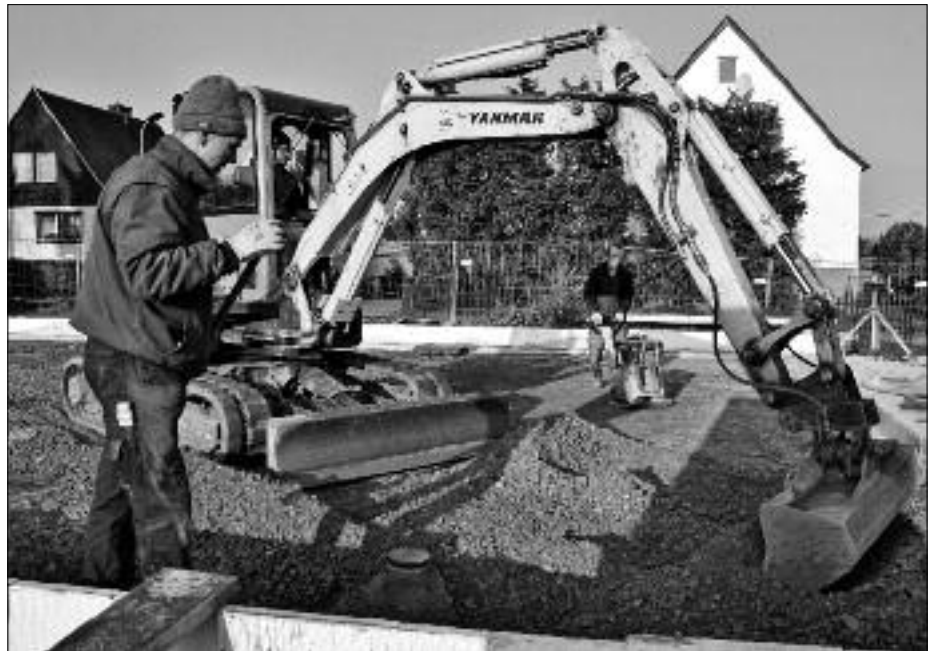
Die milde Winter-Witterung spielt den Bauleuten auf der Baustelle des Falkenauer Feuerwehrdepots in die Karten. (Foto: Knut Berger)
