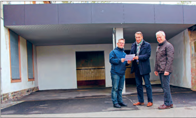
Oberbürgermeister Volker Holuscha (Mitte), Bauamtsleiter Andre Stefan (l.) waren gemeinsam mit Planer Udo Barth am 13. April vor Ort, um kurz vor der Fertigstellung des sanierten Nachtzugangs noch letzte Abstimmungen zu treffen. Foto: rs.
