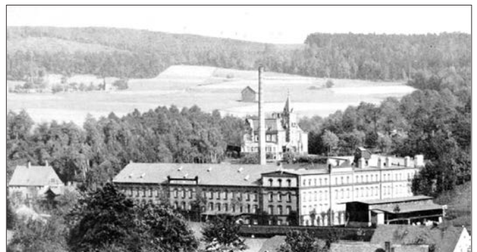
Bild 5: Die Buntpapierfabrik Gebr. Wilisch in Oberschlema in einer Aufnahme um 1920. Hinter der Fabrik die 1896 erbaute Villa von Alexander Wilisch 3)
