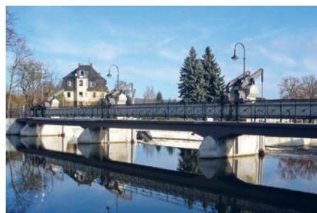
Bild 9: Das Wehr und die Wehrwarte nach der Sanierung 2009 17)
