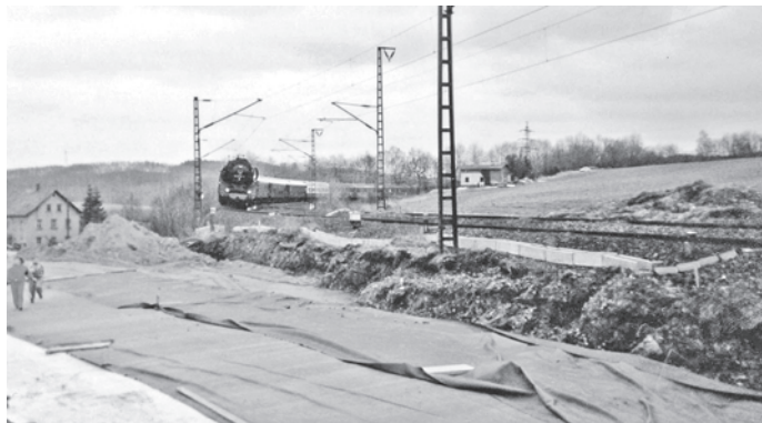
Foto 1: Der westliche Knotenpunkt der Neubautrasse Hetzdorf am Haltepunkt Falkenau Süd. Links wird am Unterbau der neuen Trasse gearbeitet, rechts fährt ein Zug aus Richtung Dresden auf der alten Trasse in den Haltepunkt ein.
