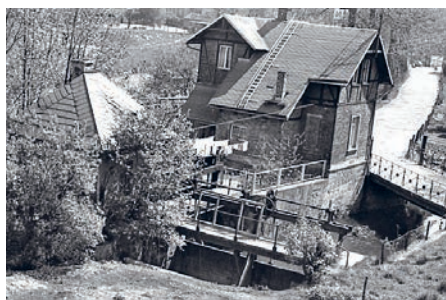
Bild 7: Der Freifluter an der Försterbrücke, Foto von 1982 16)
