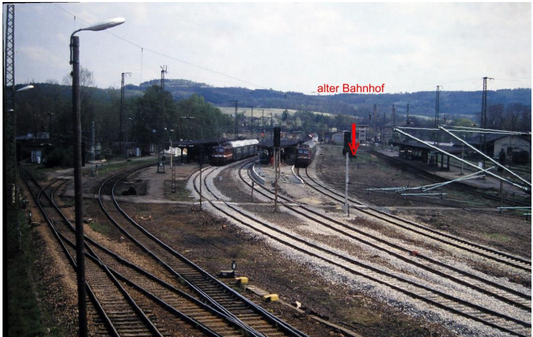
Gleisanlage von 1934, im Jahr 2014 stark zurückgebaut
