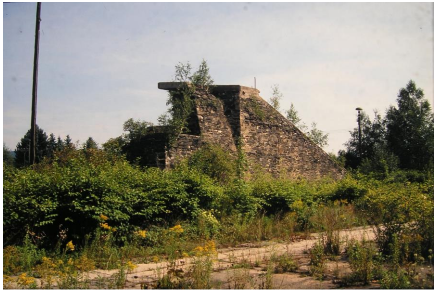
nie fertiggestellte Brückenpfeiler für die Annaberger Strecke
