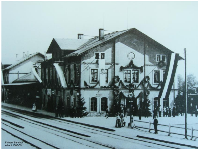
der alte Flöhaer Staatsbahnhof
