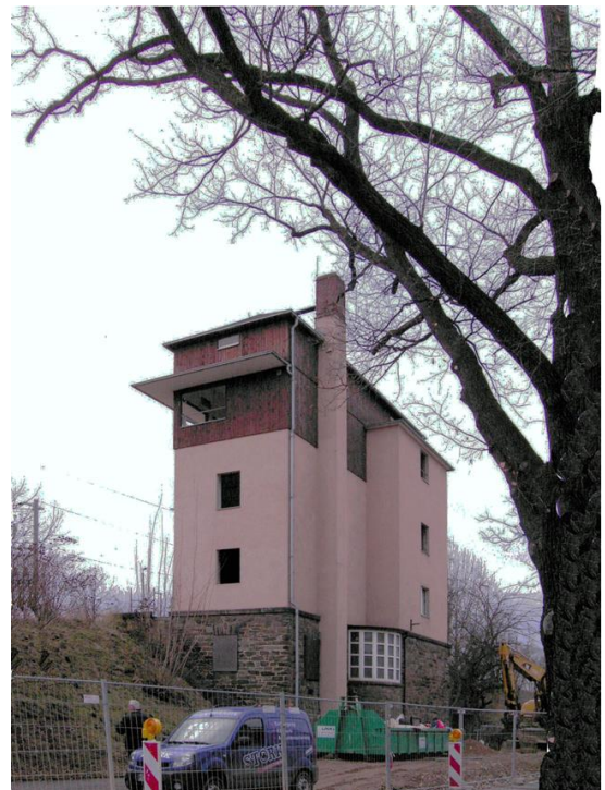
Stellwerk B2 Befehlsstellwerk
