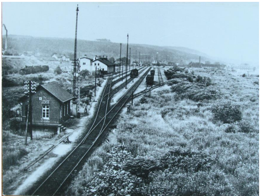
Teilansicht der Komotauer Bahnhofanlage
