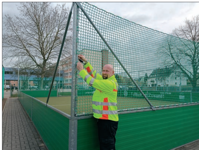
Der Objektverantwortliche des Förderzentrum Flöha Michael Frenzel, hier bei der Überprüfung der Ballfangnetzanlage, welche 2022 komplett erneuert wurde.
