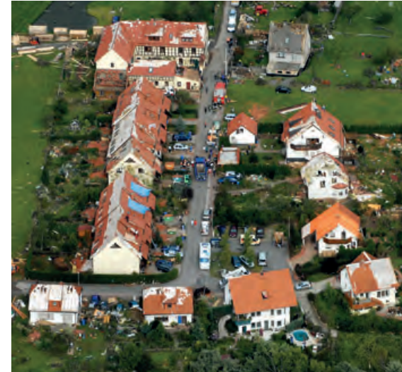
Von einem Tornado zerstörtes Wohngebiet in Quirla, Thüringen, 2006
