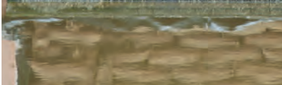
Schutzwälle aus Sandsäcken
